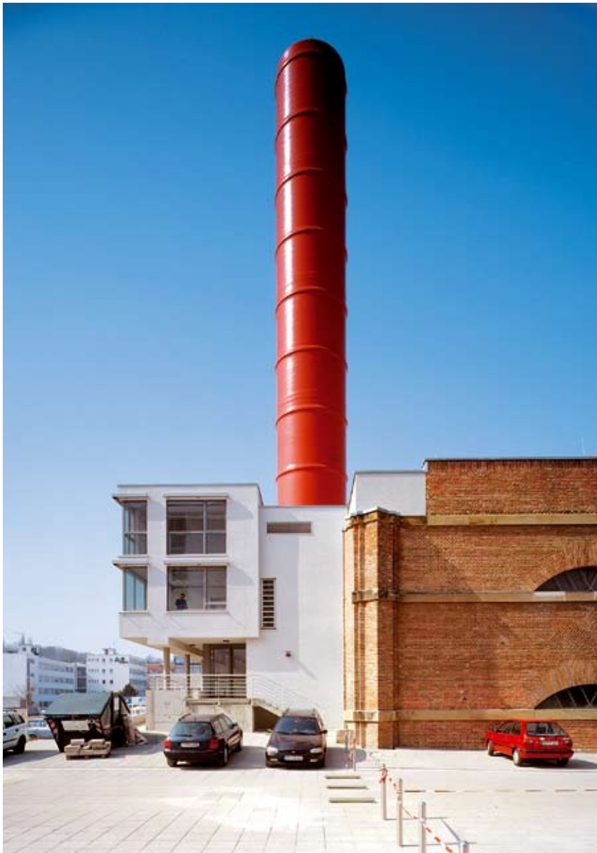
5 Der 30 m hohe Lüftungskamin ist das Wahrzeichen des Theaterhauses in Stuttgart. Bild: Dietmar Strauß.
